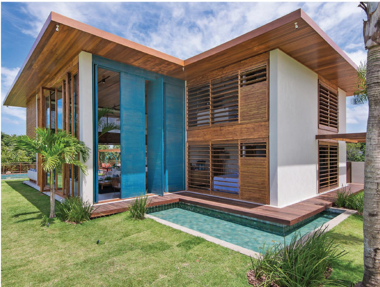
de bordo recuada, cria a sensação de que a edificação flutua no terreno. Na tentativa de minimizar a visibilidade da cobertura e disfarçar as calhas, uma testeira em madeira faz o acabamento do forro do beiral.
